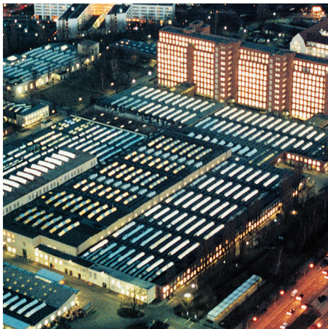
Fábrica de Interruptores Schaltwerk Berlín, Alemania
