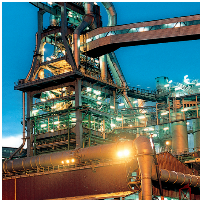
Aplicación industrial: Refinería
