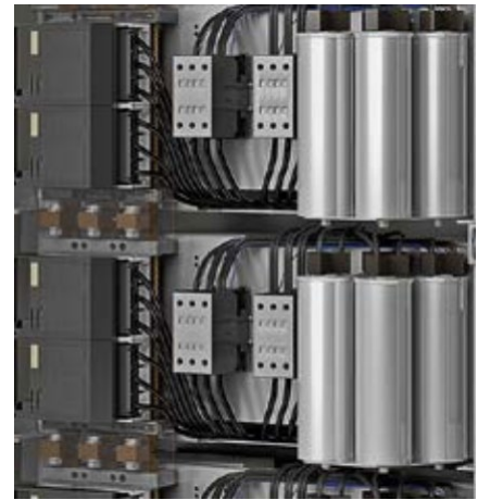
Los conjuntos de condensadores pueden utilizarse en versión estrangulada o sin estrangular.
